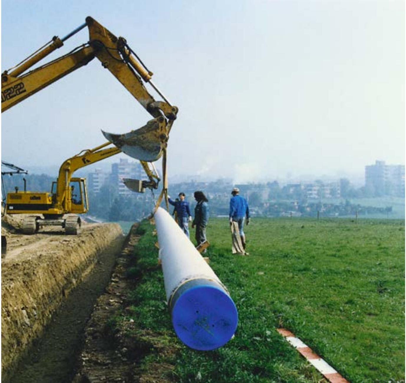
Im Juni 1990: Bagger verlegen die kilometerlangen Erdgasleitungen.
